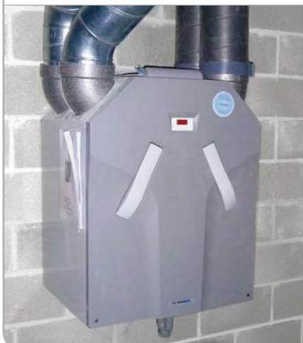
Le système de ventilation double flux, avec récupérateur de chaleur (appelé aussi échangeur), permet de réduire les pertes par ventilation dans le certificat PEB.
